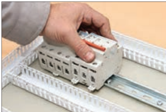
شکل ۴۶- نصب قطعات روی ریل
