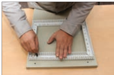
شکل ۴۱- داکت کشی روی صفحه نصب
