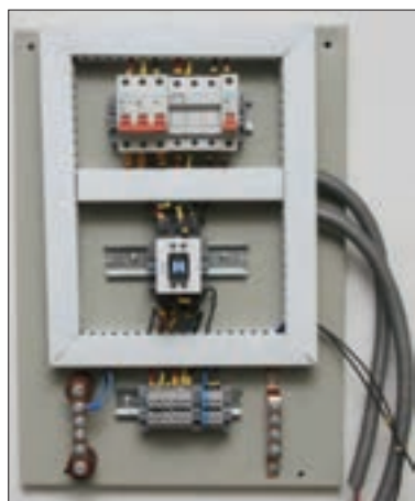
شکل ۹۱- تکمیل سیم‌کشی قطعات صفحه نصب
