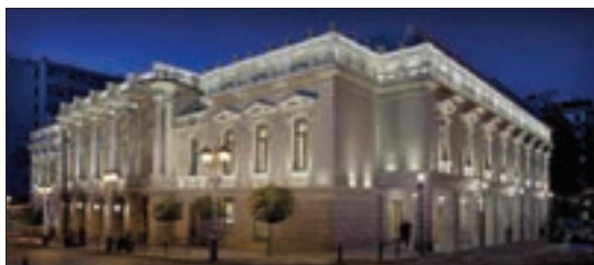
شکل ۱۰۰- روشنایی نمای ساختمان و محوطه
