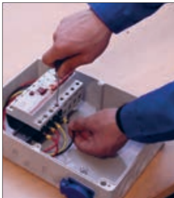
شکل ۲۲- نصب کلید جریان باقیمانده (نشتی)
