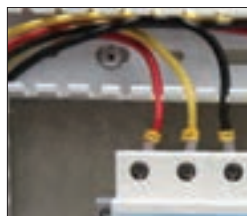
نصب درست شماره سیم
