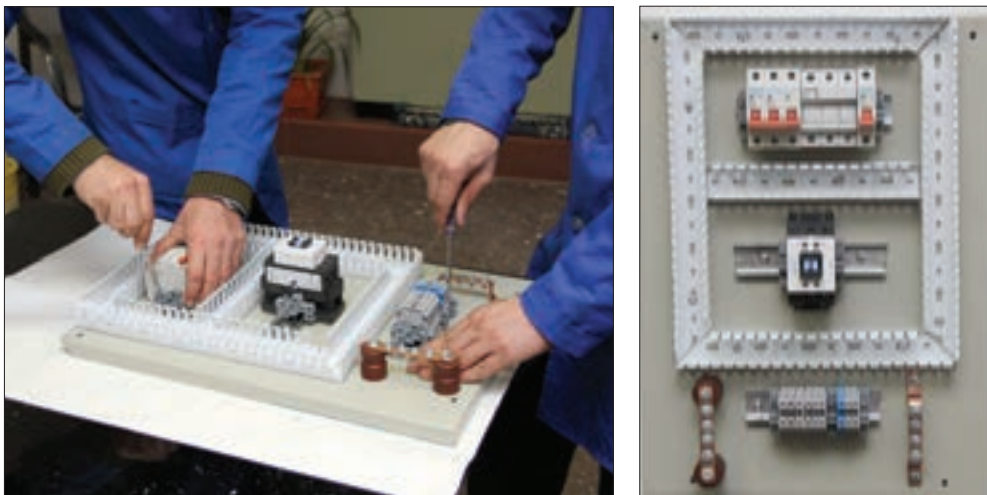
شکل ۸۴ - نصب تجهیزات دیگر
