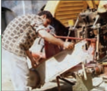
شکل ۱۵- پیاده کردن حفاظ
