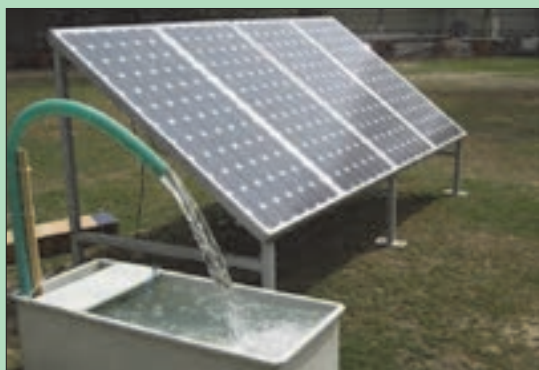
شکل ۳۸- کاربرد سامانه فتوولتاییک در پمپ چاه آب
