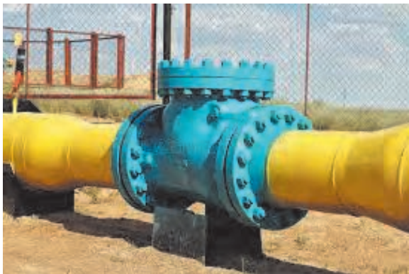
شکل ۵۰ ▲ انواع اتصال فلنجی
