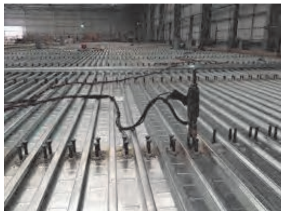
شکل ۳۴ ▲ روش نصب گل‌میخ روی سقف عرشه فولادی
