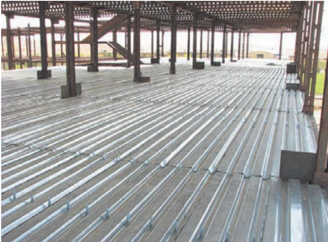
شکل ۳۳ ▲ سقف عرشه فولادی
