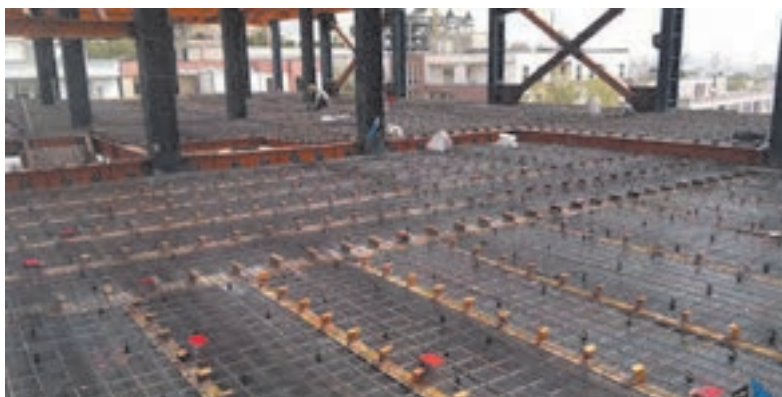
شکل ۳۲ ▲ سقف مرکب به همراه برشگیرها
