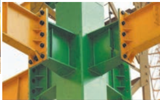
شکل ۵۰ ▲ انواع اتصال فلنجی
