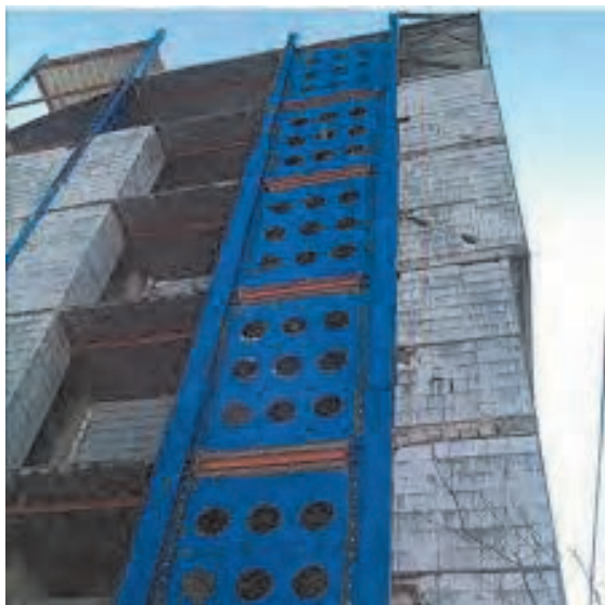
شکل ۶۱ ▲ دیوار برشی فولادی
