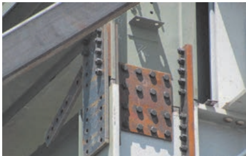
شکل ۵۷ وصله پیچی ستون
