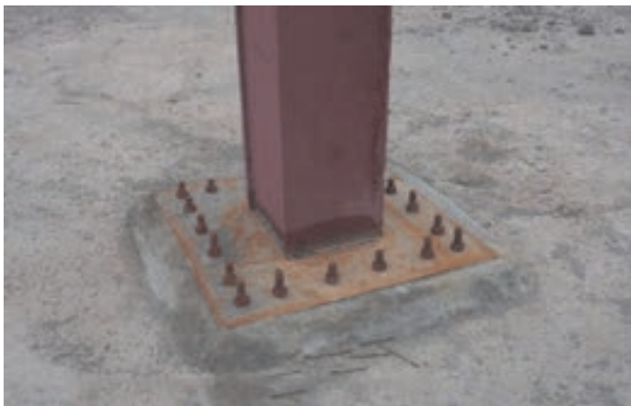
شکل ۴۹ ▲ اتصال مستقیم ستون به کف ستون
