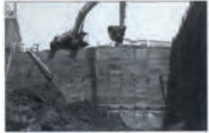
شکل ۱- ضرورت رعایت ایمنی در عملیات گودبرداری
