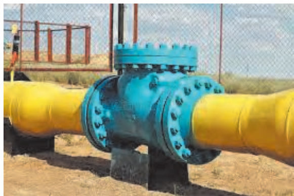
شکل ۵۰ ▲ انواع اتصال فلنجی
