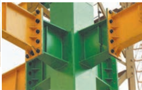
شکل ۵۰ ▲ انواع اتصال فلنجی
