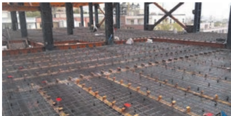
شکل ۳۲ ▲ سقف مرکب به همراه برشگیرها
