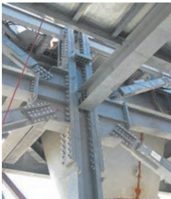
شکل ۵۱ ▲ اتصال مهاربندی
