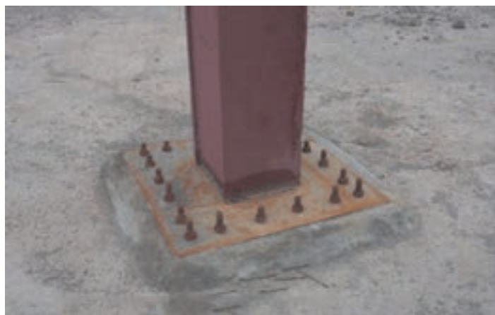
شکل ۴۹ ▲ اتصال مستقیم ستون به کف ستون
