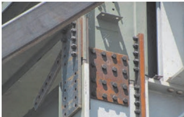
شکل ۵۷ وصله پیچی ستون
