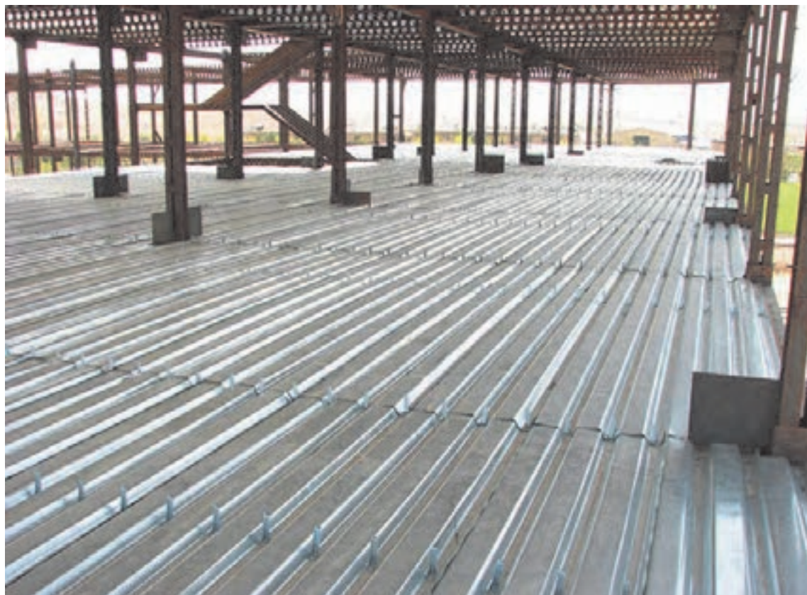
شکل ۳۳ ▲ سقف عرشه فولادی
