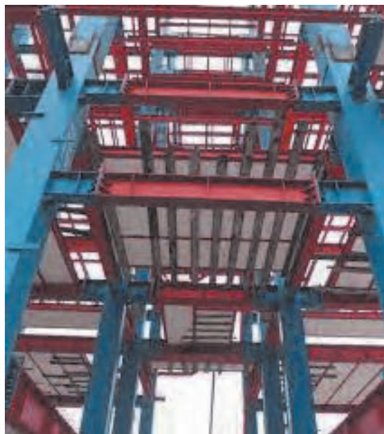
شکل ۶۰ ▲ قاب خمشی
