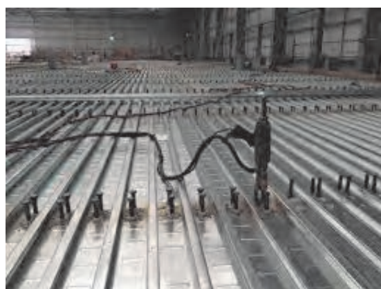
شکل ۳۴ ▲ روش نصب گل‌میخ روی سقف عرشه فولادی
