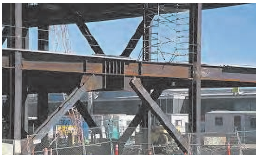
شکل ۲۷ ▲ مهاربند دوزنقه‌ای
