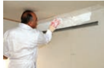
شکل ۲۳۷-۱- اجرای اندود گچ
