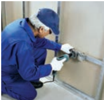
شکل ۱-۱۶۹- اتصال قوطی برق به سازه پشتیبان
