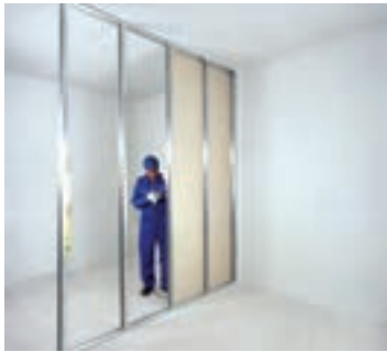
شکل ۱-۶۲- اجرای پانل‌ها در یک طرف دیوار
