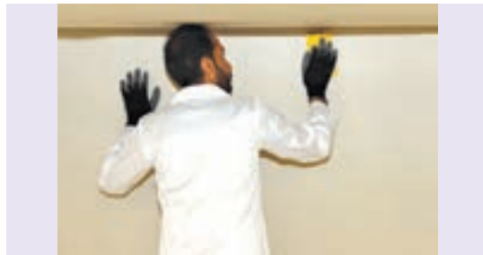
شکل ۲۲۵-۱- تمیز کردن سطح کار
