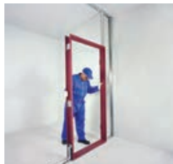
شکل ۱-۱۱۹- استقرار چهارچوب در
