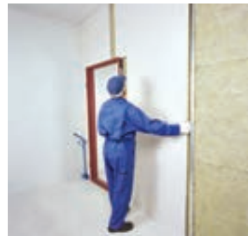
شکل ۱۴۳-۱- اجرای پانل چهارم دور چهار چوب
