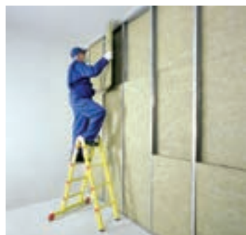
شکل ۸۷-۱- اجرای عایق پشم معدنی شکل ۸۸-۱- اجرای پانل‌ها در هر طرف دیوار شکل ۸۹-۱- اجرای لایه دوم پانل‌ها
