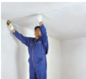
شکل ۴۷-۱ مشخص کردن محل نصب رانر سقف با ریسمان رنگی
