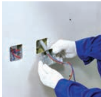
شکل ۱-۱۷۱- خروجی های تأسیساتی به وسیله اره و سوهان ایجاد می شوند (در نصب قوطی های فلزی برق با سازه پشتیبان، برش کاری خروجی، قبل از نصب پانل صورت می گیرد)
