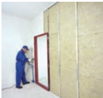
شکل ۱-۱۴۲- پیچ زنی پانل در حاشیه دور چهارچوب
