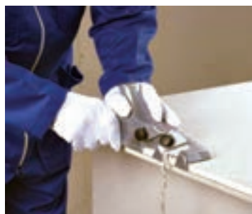
شکل ۱-۱۹۱- پخ زدن لبه‌ها
