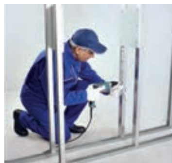
شکل ۱-۱۵۴- اتصال قطعات نبشی L۲۵ به استادهای مجاور
