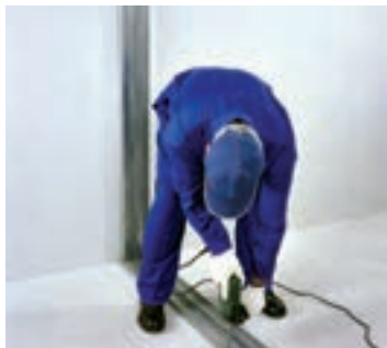
شکل ۸۰-۱- اجرای قاب پیرامونی دوم
