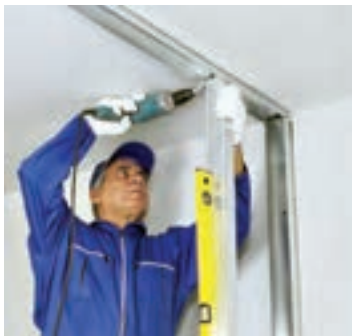
شکل ۱-۱۱۸- اتصال بالای استاد با پیچ LB
