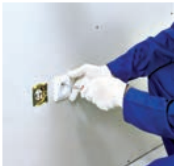
شکل ۱۷۱- پس از نصب قوطی، پریش برق نصب می‌گردد.
