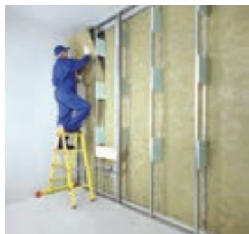
شکل ۹۹-۱- اجرای عایق معدنی
