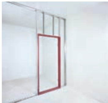
شکل ۱-۱۳۵- قاب‌بندی و تقویت بازشوی در تکمیل شده است.
