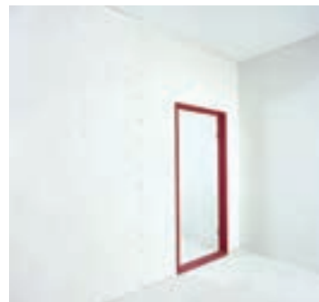
شکل ۱-۱۴۰- پانل‌گذاری در یک سمت دیوار تکمیل شده
