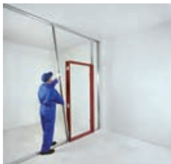
شکل ۱-۱۲۰- نصب استاد دوم
