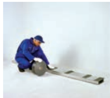
شکل ۸۱-۱- اجرای نوار عایق بر روی استاداها
