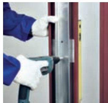
شکل ۱۲۵- چهارچوب توسط پیچ LB در محل صفحات به استادهای متصل می‌شود. شکل ۱۲۶- علامت‌گذاری انتهای رانر نعل درگاه به صورت فارسی بر (به اندازه ۲۰ سانتی‌متر) شکل ۱۲۷- برش انتهای رانر نعل درگاه
