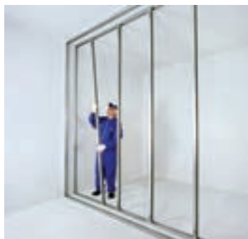
شکل ۱-۹۵- اجرای ردیف اول استادها
