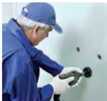
شکل ۱۰۲-۱- ایجاد خروجی تأسیسات به وسیله گرد بر
