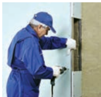
شکل ۱۰۰-۱- اجرای پانل‌ها در طرف دیگر دیوار
