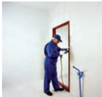
شکل ۱۴۴-۱- پیچ زنی در حاشیه چهار چوب و تکمیل پوشش کاری
