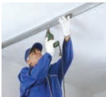
شکل ۴۸-۱ نصب رانر سقف
