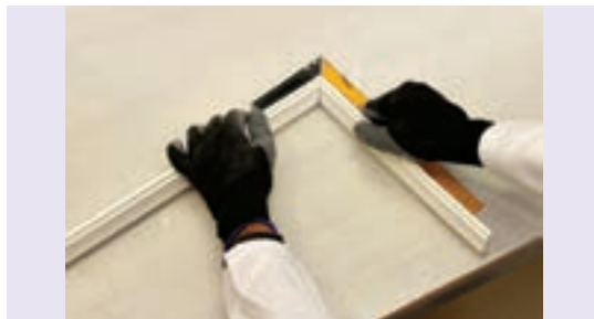
شکل ۲۲۹-۱- کنترل گونیا بودن قطعات قبل از نصب
