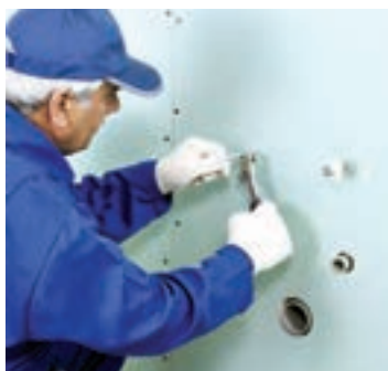
شکل ۱-۱۵۸- اتصال مهار روشویی به تراورس
