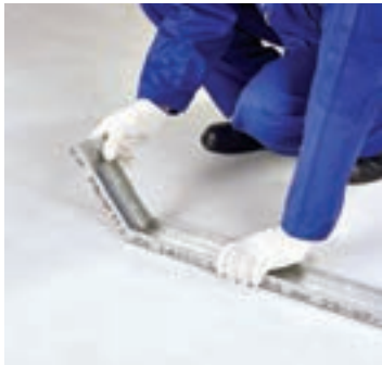
شکل ۱-۱۱۵- خم کردن انتهای رانر کف
