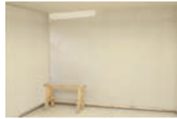
شکل ۲۳۴-۱- اجرای بتونه (زیر سازی)
