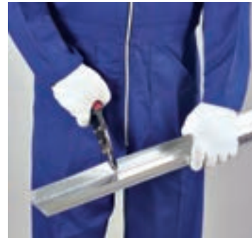
شکل ۱-۱۱۳- برش انتهای رانرهای کف
