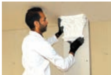
شکل ۲۴۲-۱- اتصال قطعه اول به ستون
