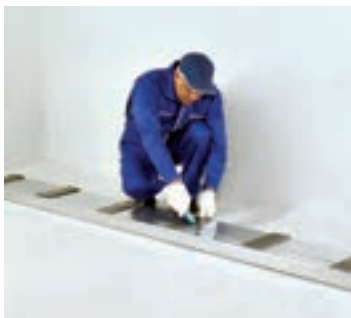
شکل ۸۲-۱- برش نوارهای عایق
