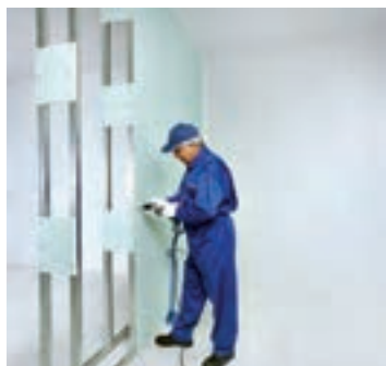
شکل ۹۸-۱- اجرای پانل‌ها در یک طرف دیوار
