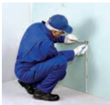
شکل ۱-۱۵۶- تعیین محل خروجی‌های تأسیساتی
