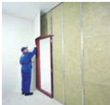
شکل ۱-۱۴۱- اجرای پانل سوم دور چهارچوب پس از عایق‌گذاری (پانل‌ها نسبت به سمت اول به شکل حصیرچین اجرا می‌شوند).
