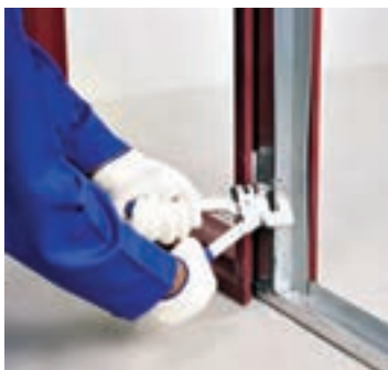
شکل ۱-۱۲۱- اتصال پایین استاد با پانچ
