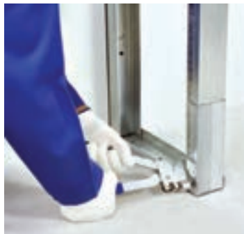
شکل ۱-۱۱۷- اتصال پایین استاد با پانچ
