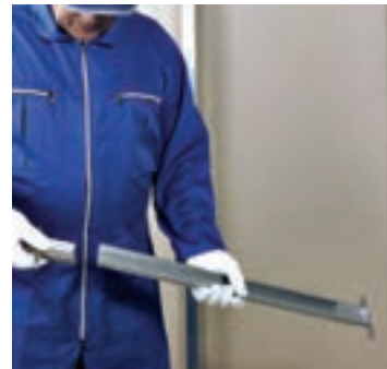
شکل ۱-۱۶۷- قطعه اتصال پشتیبان به صورت کشویی در سازه F۴۷ قرار داده می شود.
