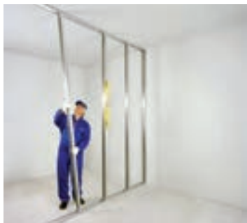
شکل ۸۳-۱- اجرای ردیف اول استاداها (به صورت شاقولی)
