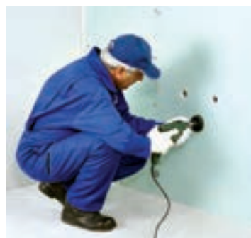
شکل ۱-۱۵۷- ایجاد خروجی‌های تأسیساتی به وسیله گردبر
