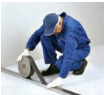
شکل ۴۴-۱- اجرای نوار عایق (با دوردیف سیلیکون) بر پشت جان رانر کف و سقف
