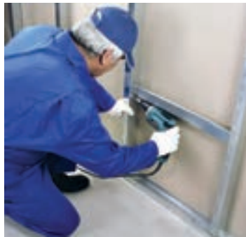
شکل ۱-۱۶۸- اتصال سازه پشتیبان به استادهای مجاور
