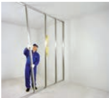
شکل ۱-۵۴ - اجرای استادها ( به صورت شاقولی)
