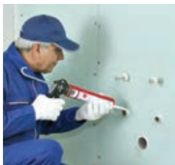
شکل ۱-۱۵۹- اجرای خمیر درزبند در اطراف خروجی‌های تأسیساتی
