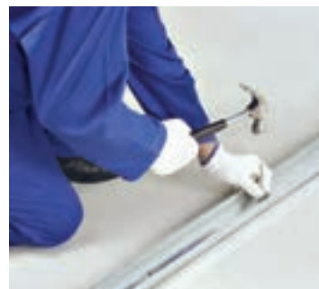
شکل ۴۲-۱- اتصال رانر به کف با رول پلاک
