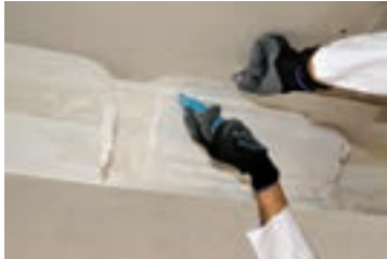
شکل ۲۳۹-۱- تمیز کردن اطراف کار
