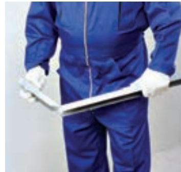
شکل ۱۲۸-۱- خم کردن انتهای رانر نعل درگاه
