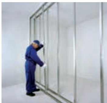
شکل ۱-۹۶- شاقولی کردن ردیف اول استادها
