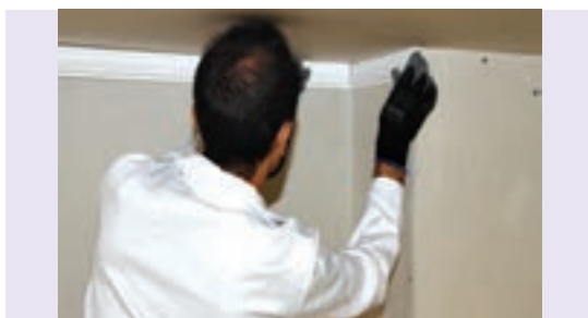
شکل ۲۳۲-۱- نصب قطعه نهایی
