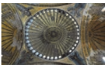
شکل ۹۴-۱- سقف گنبدی و نورگیرهای سقفی ایاصوفیه
