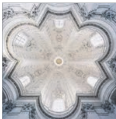
شکل ۱-۱۰۵- سقف فضای داخلی کلیسای سنت ایوو دلاساپینزا
