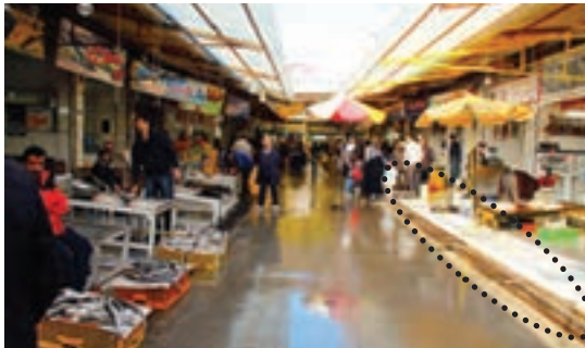
شکل ۲۵-۲- کف قابل شست‌وشو و مسیر جمع‌آوری آب‌بارپوش مشبک در وسط مسیر عبور در بازار ماهی‌فروش‌ها.
