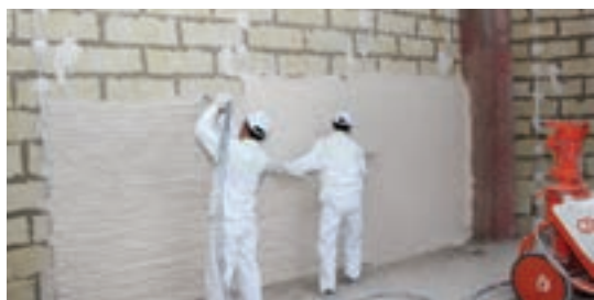
شکل ۱۴-۲ به علت سرعت بالای اجرای اندود، هم زمان با پاشش آن باید شمشه کشی انجام گیرد.
