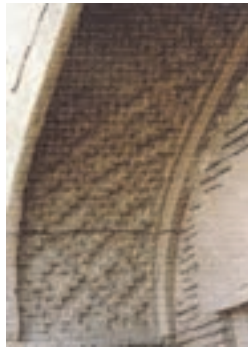
شکل ۲-۶۹- دزفول، آجرکاری هشت و گیر
