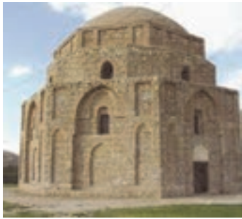
شکل ۱۰۶-۲- کرمان، گنبد جبلیه، سنگ لاشه و ملات
