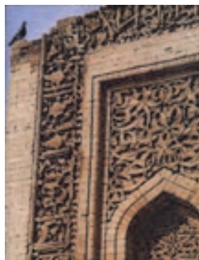
شکل ۶۰-۲- بخارا، آجر تراش، سردر بنایی در دوره سلجوقی
