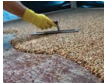
شکل ۳-۴۳- نمایش نحوه پخش و اجرای اپوکسی گرانیته
