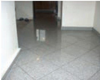
شکل ۳-۴۵- کف‌سازی نهایی با پوشش اپوکسی گرانیته شطرنجی
