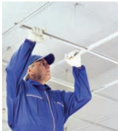
شکل ۱۲۱-۳- اجرای سازه‌های فرعی T ۶۰۰ شکل ۱۲۲-۳- تنظیم ارتفاع سقف
