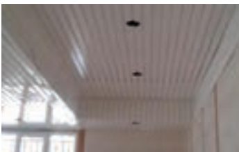
شکل ۳-۳- سقف کاذب فلزی
