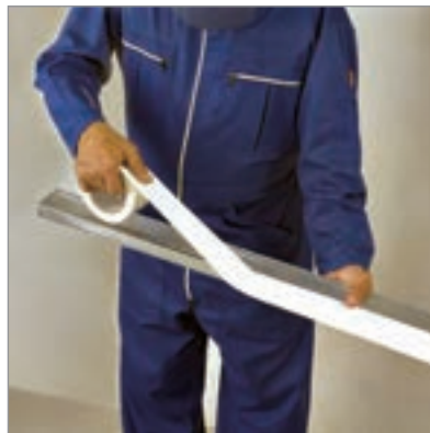
شکل ۸۵-۳- چسباندن نوار ترن فیکس بر روی سازه
