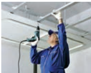
شکل ۳-۵- سقف کاذب با صفحات روکش دار گچی
