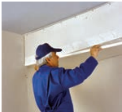
شکل ۸۴-۳- قرار دادن نوار درزگیر بر روی بتونه
