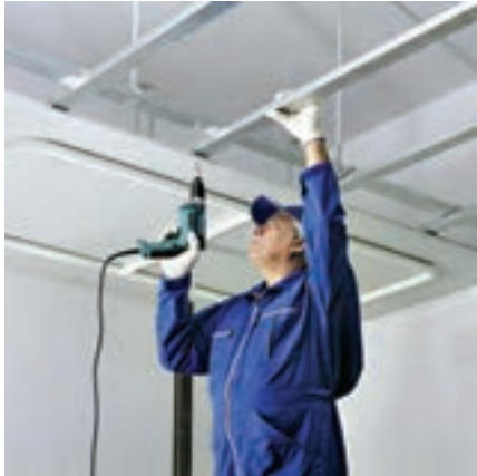
شکل ۳-۶۷ اتصال پانل به زیرسازی توسط پیچ
