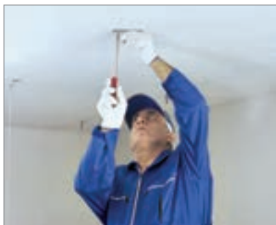
شکل ۳-۱۱۶- اتصال قطعه HT ۹۰ به سقف اصلی شکل ۳-۱۱۷
