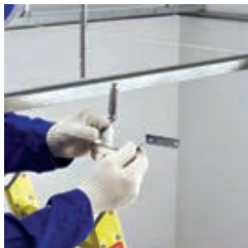
شکل ۳-۵۶- باز کردن رکاب
