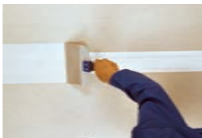
شکل ۸۲-۳- قرار دادن نوار درزگیر بر روی بتونه
