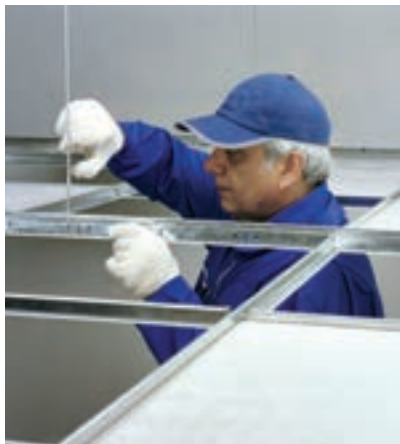
شکل ۱۲۱-۳- اجرای سازه‌های فرعی T ۶۰۰ شکل ۱۲۲-۳- تنظیم ارتفاع سقف
