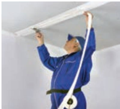
شکل ۸۱-۳- اجرای لایه بتونه در محل درز (کاردک در جهت عمود بر درز کشیده می شود تا بتونه کاملاً در درز نفوذ کند).
