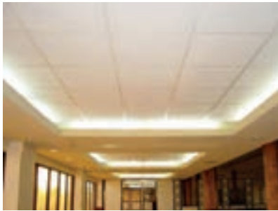
شکل ۱۱۰-۳- اجرای کامل سقف مشبک به روش قرینه‌سازی
