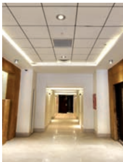
شکل ۹۳-۳- نمونه تمام شده سقف کاذب مشبک
