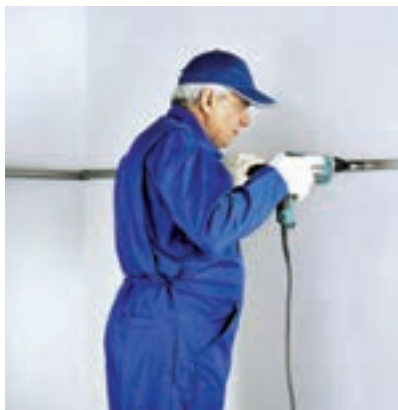
شکل ۳-۴۵- نصب سازه تراز
