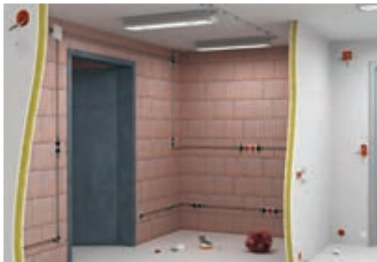
شکل ۳-۳۳- سیم‌کشی توکار
