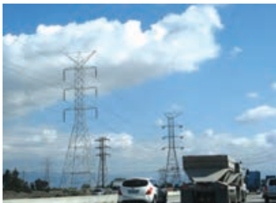
شکل ۵-۳- انتقال انرژی الکتریکی توسط دکل ها
