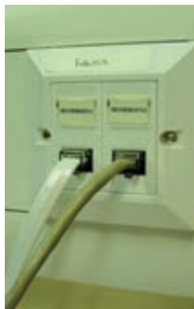
شکل ۲۶-۳- تصویر ظاهری و شمای فنی پریز تلفن
