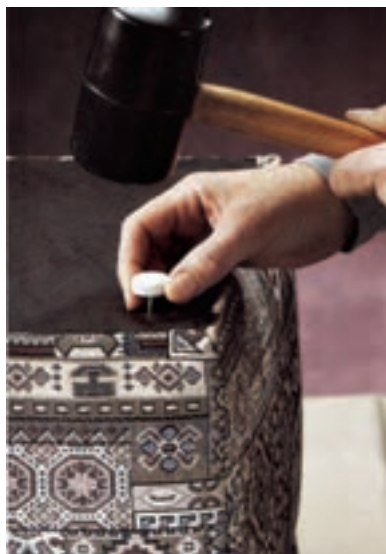
شکل ۴۳-۴- کوبیدن پایهٔ زیر کف
