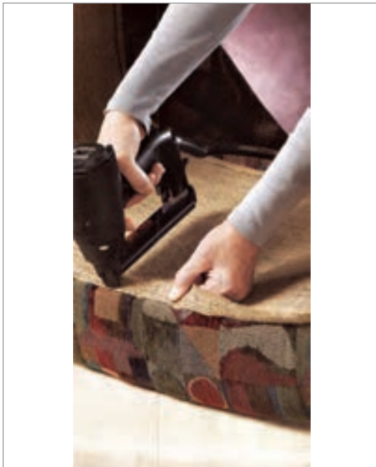
شکل ۴-۲۸- نصب گونی در زیر نیمکت
