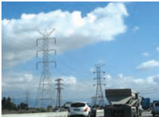
شکل ۵-۳- انتقال انرژی الکتریکی توسط دکل ها
