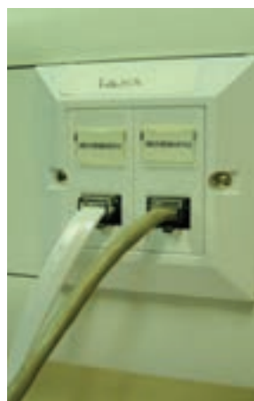
شکل ۲۶-۳- تصویر ظاهری و شمای فنی پریز تلفن
