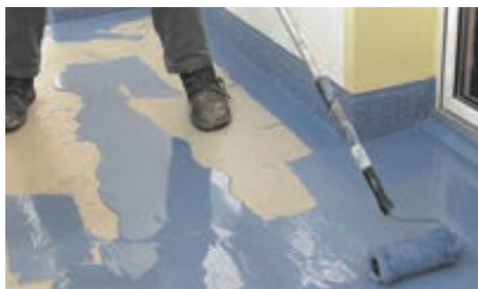
شکل ۴-۱۰- یکی از روش‌های اجرای اپوکسی
