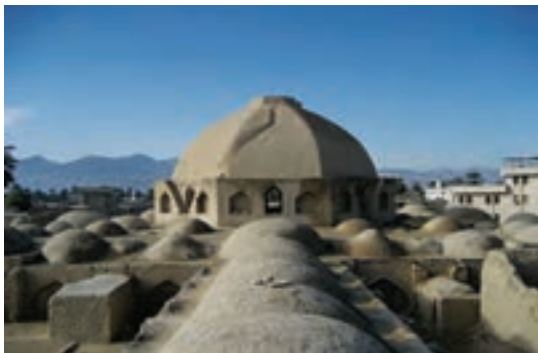
شکل ۱-۱۲- بام سرپوشیده با گنبد‌های گلی بازار قیصریه لار
