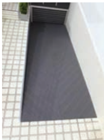
شکل ۱۱۰-۵- اجرای شیارهای رامپ با کاتر و فشار دست
