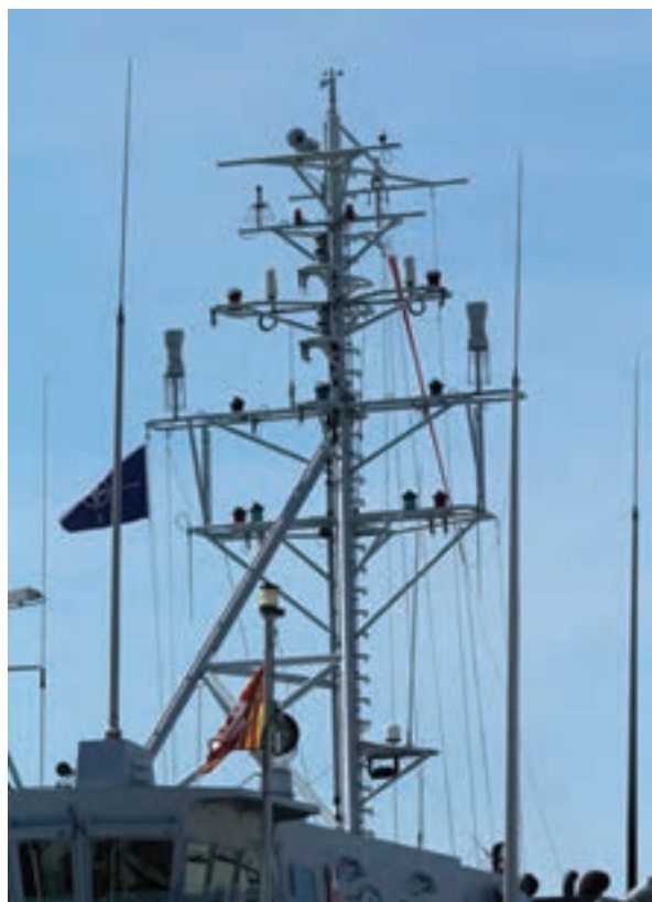
شکل ۳۲- محل نصب چراغ‌ها ناوبری
