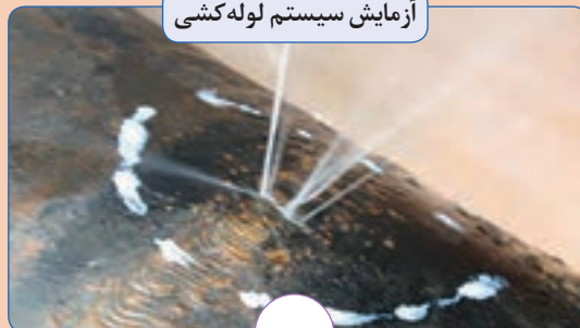
آزمایش سیستم لوله کشی
