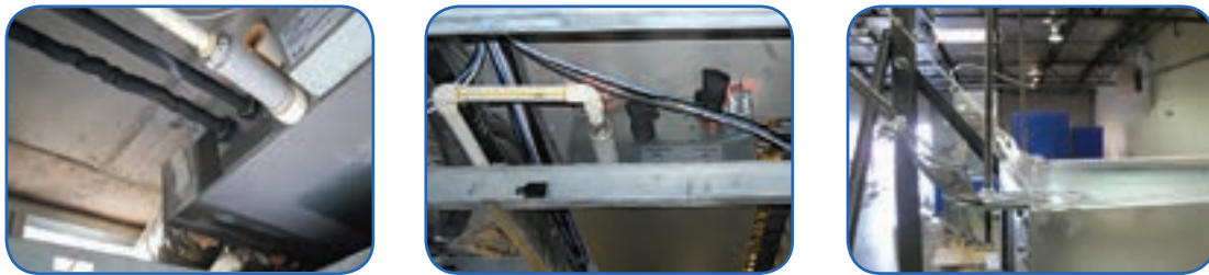
شکل ۸- نمونه اتصال لوله تخلیه به تشتک
