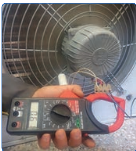
شکل ۱۵- اندازه گیری میزان شدت جریان (آمپر) موتور یونیت هیتر
