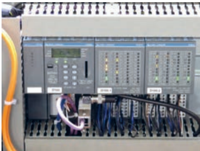
شکل ۸- PLC به همراه دو عدد ماژول ورودی و خروجی
