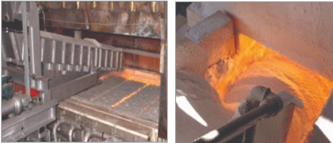
شکل ۲۳- ریختن آمیز به درون کوره
