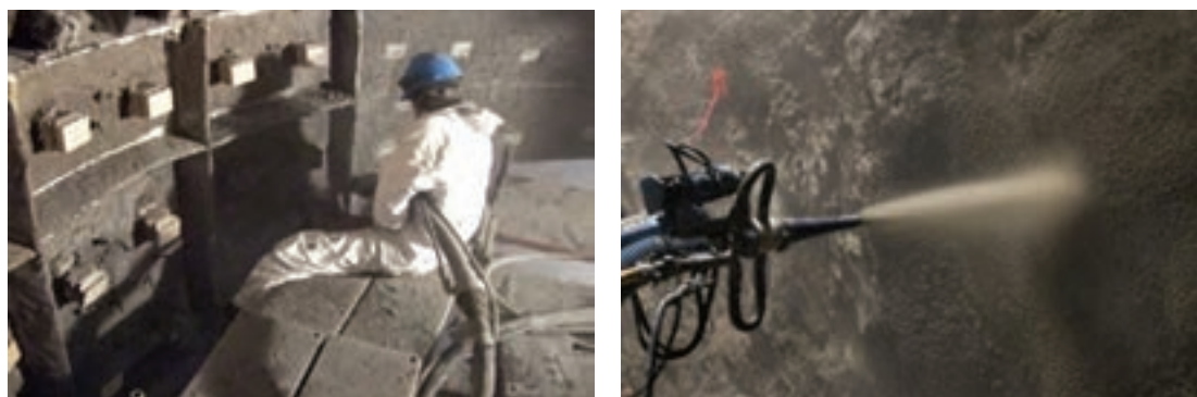
شکل ۲۸- نصب جرم با روش پاشش
