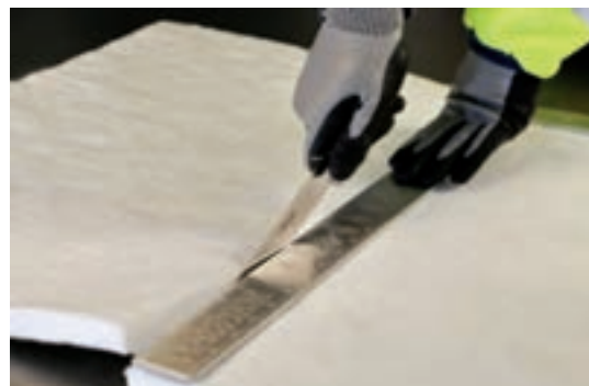
شکل ۴۴ - برش دادن عایق‌های ساخته شده از الیاف دیرگداز
