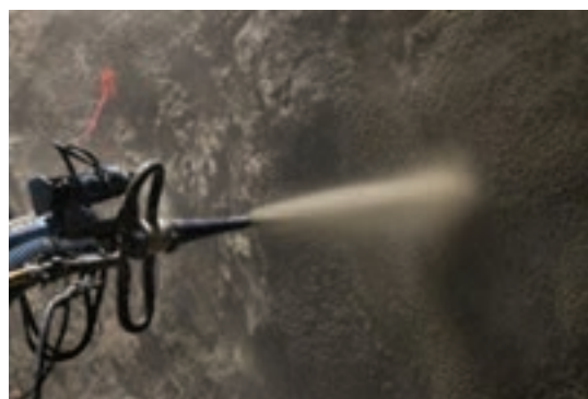
شکل ۲۸- نصب جرم با روش پاشش
