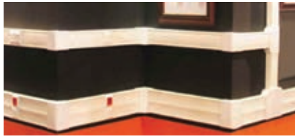
شکل ۵۳ - محل تقاطع ترانک‌ها و داکت‌ها
