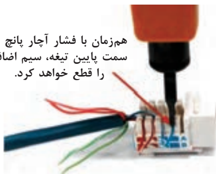
شکل ۳۳- قرار دادن سیم‌ها در کیستون به کمک آچار پانچ
