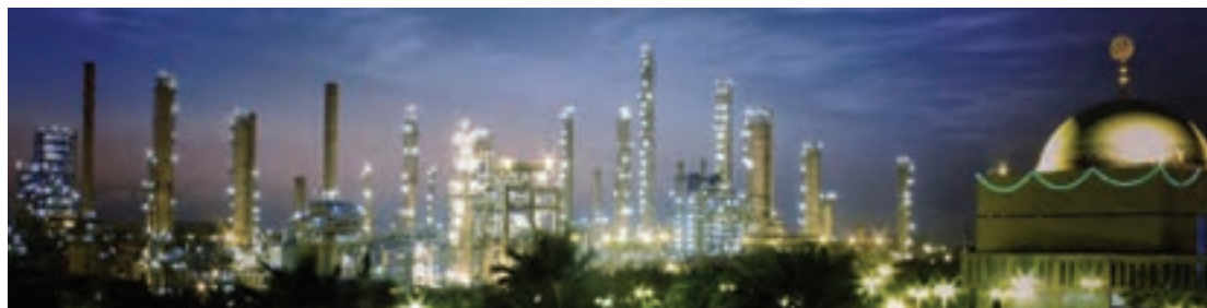
شکل ۲- یکی از مجتمع‌های پتروشیمی
