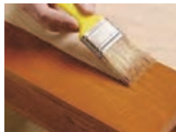
شکل ۵۷- روغن اندود کردن سطح کار
