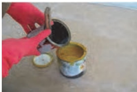
شکل ۸۵- اضافه کردن روغن جلا به رنگ روغنی
