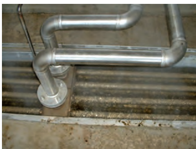
شکل ۶۱- کویل‌های حرارتی برای گرم کردن هوای کوره
