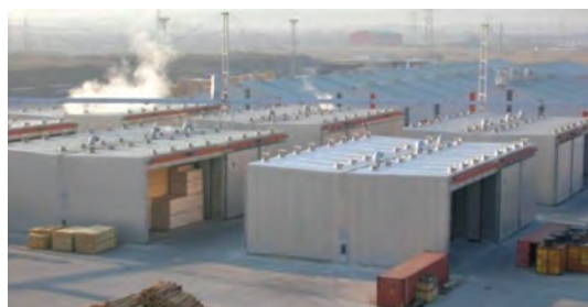
شکل ۲۹- کوره‌های چوب خشک‌کنی ساخته شده با آلومینیوم
