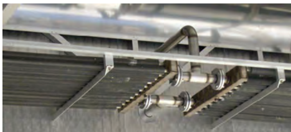
شکل ۴۱- انتقال حرارت کویل‌ها با هوای اطراف خود
