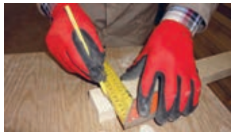
شکل ۸۷- علامت زدن قطعات مختلف برای انجام اتصال
