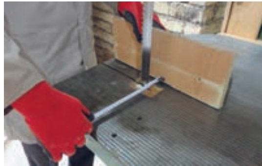
شکل ۷۴- اندازه‌گیری فاصله تیغه با گونیا
