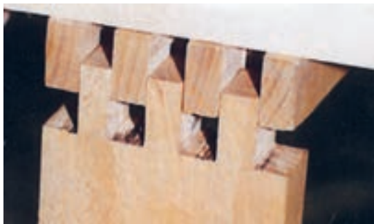
شکل ۱۲- اتصال انگشتی با تعداد زبانه فرد
