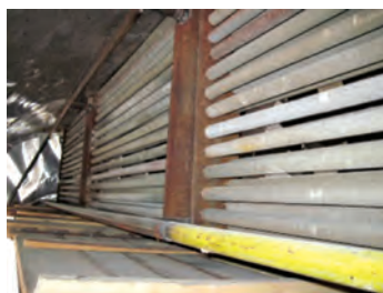
شکل ۳۸- نحوه قرارگیری کویل‌های حرارتی
