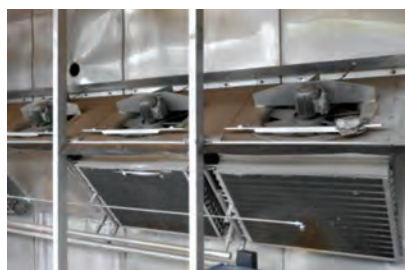
شکل ۴۰- انتقال حرارت کویل‌ها به وسیله فن‌ها
