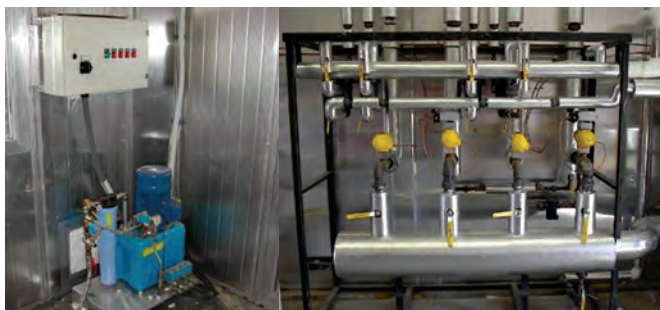
شکل ۶۰- شیرهای کنترل بخارزنی
