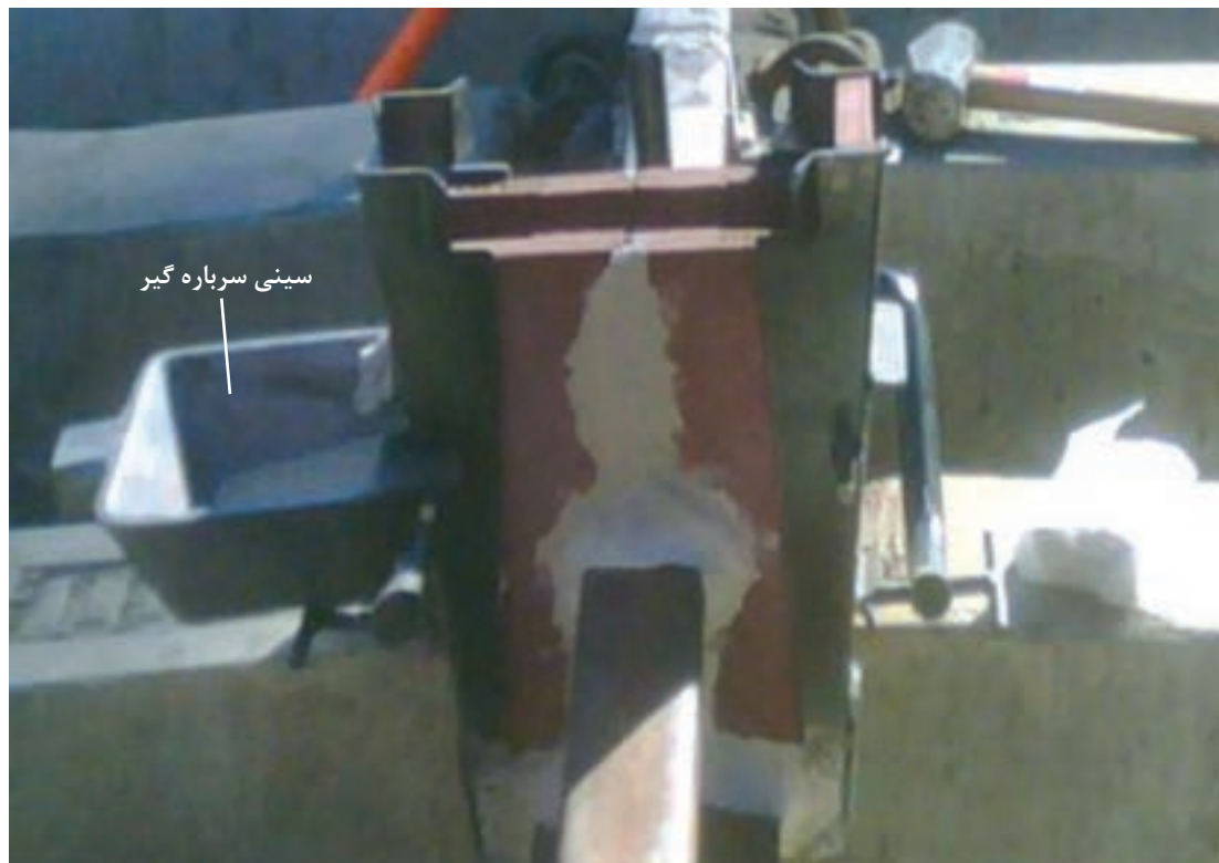
شکل ۲۰- نصب سینی‌های سرباره گیر
