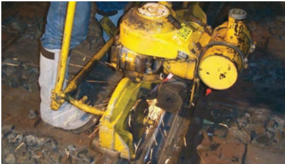
شکل ۲۹- سنگ زنی و پرداخت کاری سطح گرده
