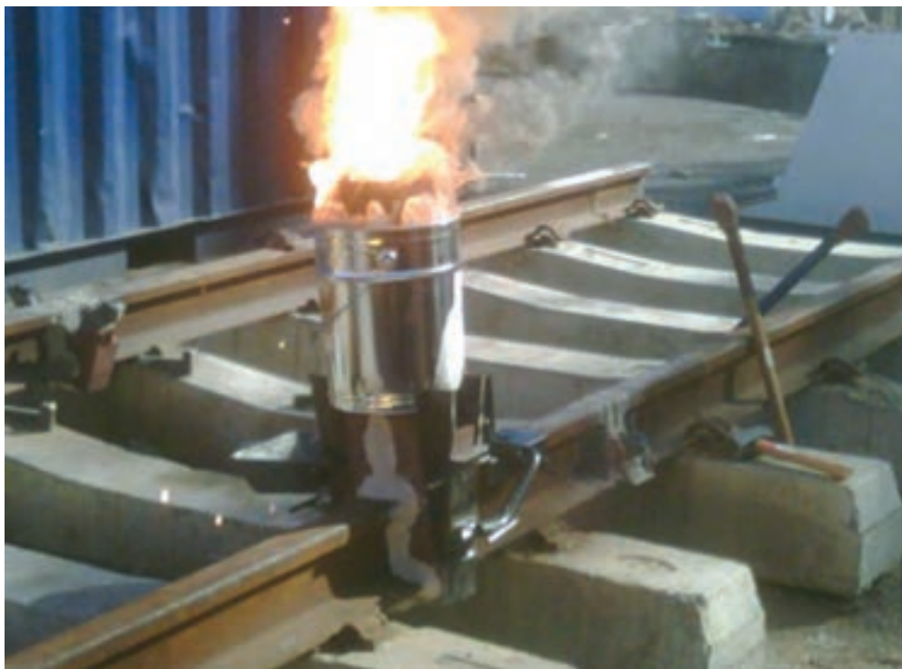
شکل ۲۴- نمایی از انجام واکنش ترمیت
