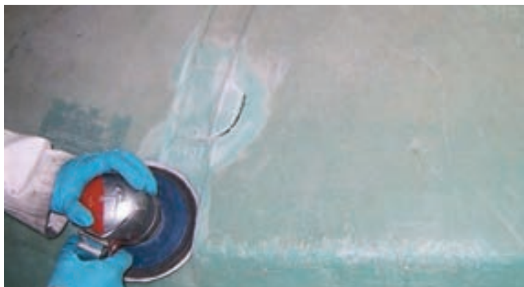
شکل ۲۶- آماده سازی سطوح پلاستیکی قبل از جوشکاری
