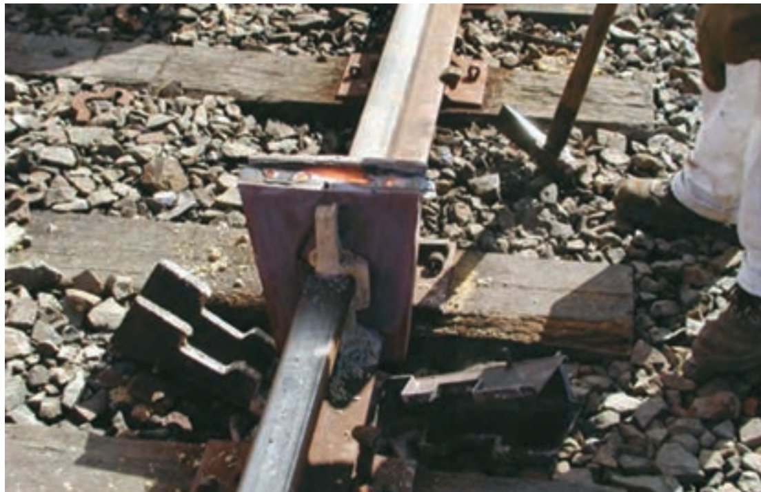
شکل ۲۶- باز کردن گیره و حفاظ قالب
