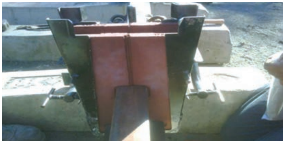
شکل ۱۸- نصب قالب اطراف ناحیه اتصال
