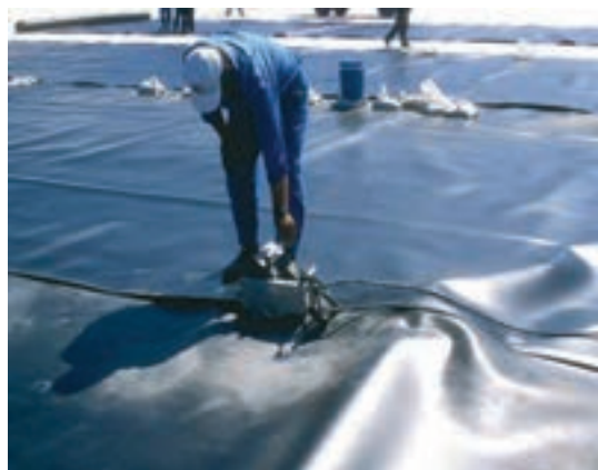
شکل ۱۳- دستگاه جوشکاری گاز داغ و جوشکاری با گاز داغ به صورت ماشینی
