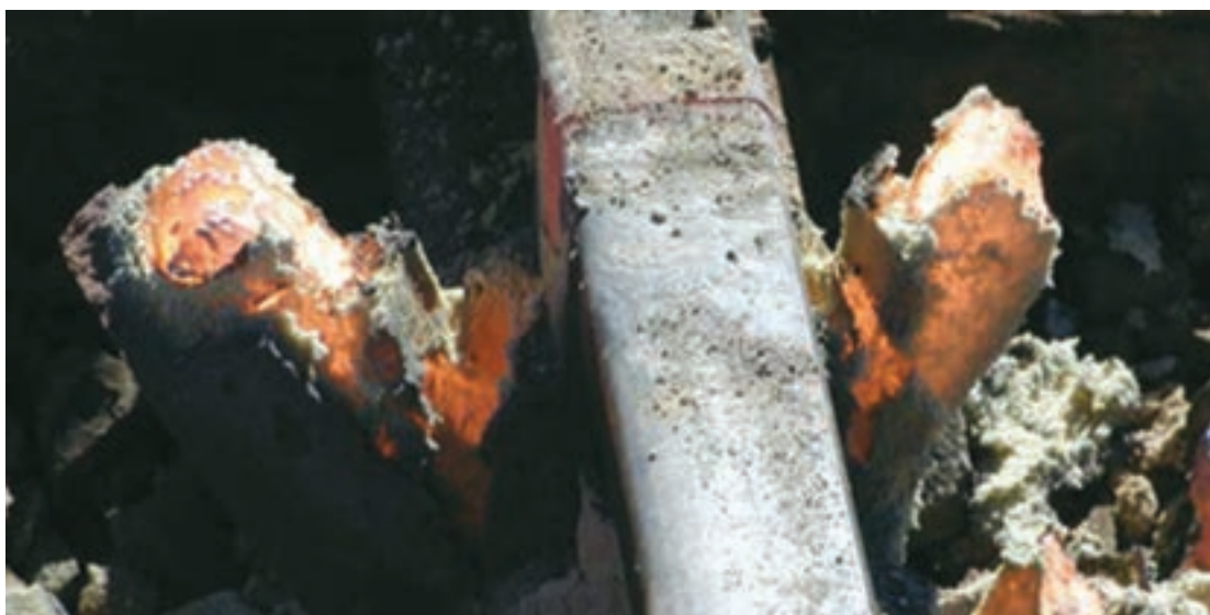
شکل ۲۸- برش گرده اضافی جوش
