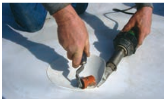
شکل ۱۲- جوشکاری با گاز داغ به صورت دستی
