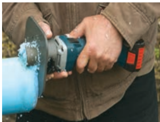
شکل ۲۴- پخ زدن قطعات پلاستیکی برای جوشکاری
