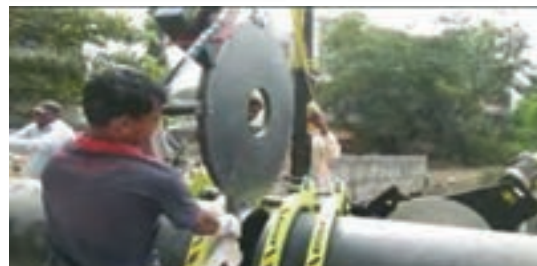
شکل ۱۹- جوشکاری لب به لب Butt Fusion
