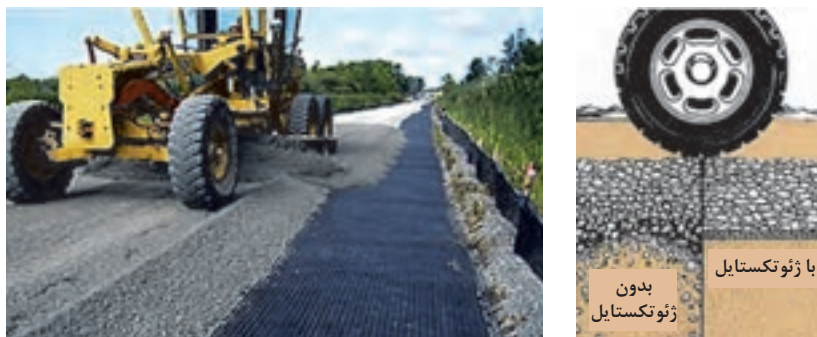
شکل ۲۵- کاربرد پارچه‌های ژئوتکستایل در زیرسازی راه
