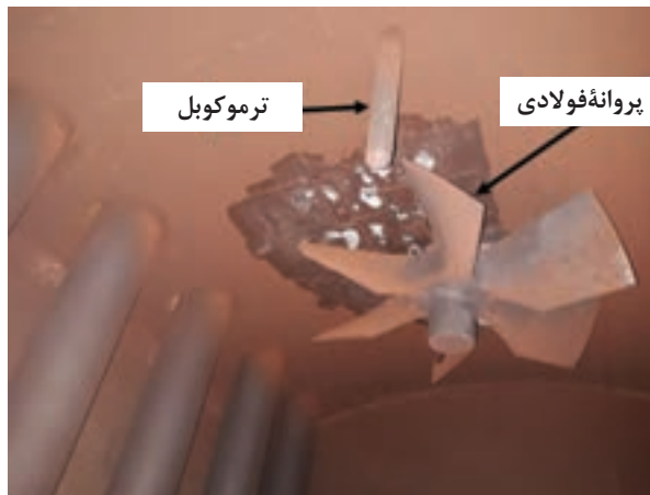
شکل ۱۹- فن گردش هوا در داخل کوره
