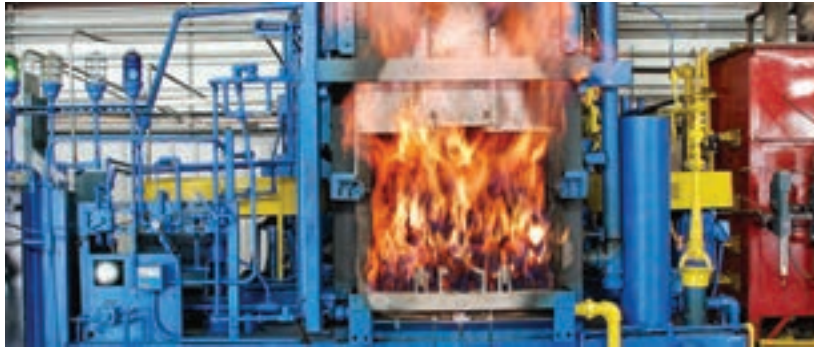
شکل ۸- کوره با اتمسفر کنترل شده
