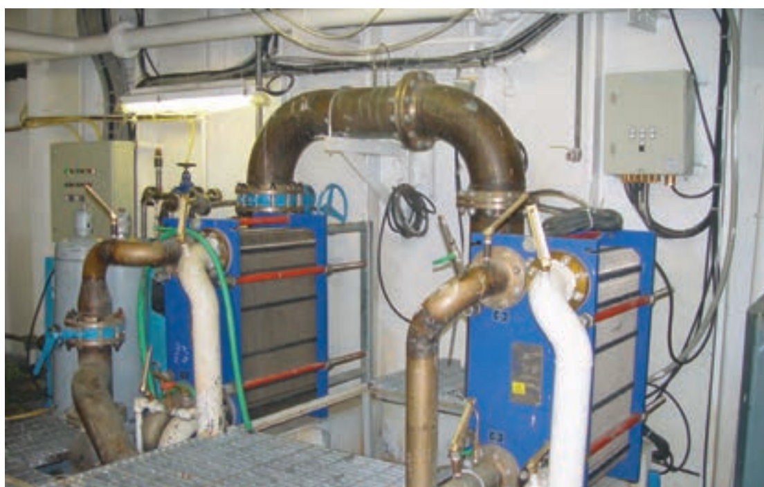
شکل ۶ - سامانه خنک کاری آب دریا
