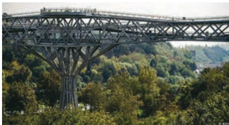
شکل ۱۰- نمونه‌ای از سازه‌های خرپا
