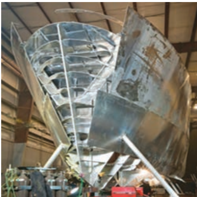
شکل ۲۳- سازهٔ سینهٔ یک شناور در حال ساخت
