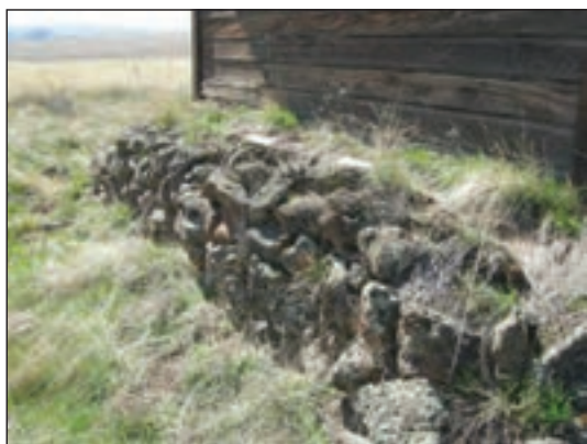
شکل ۳-۴۰ پی سنگی با سنگ لاشه
