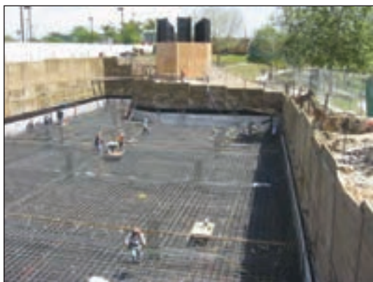
شکل ۳-۶۸ پی بتن مسلح یکپارچه (رادیه ژنرال)
