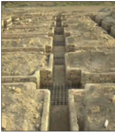
شکل ۳-۵۴ آرماتورگذاری پی تکی کلاف بندی شده
