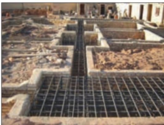
شکل ۳-۱۳۴ میلگردگذاری در پی کلاف‌بندی
