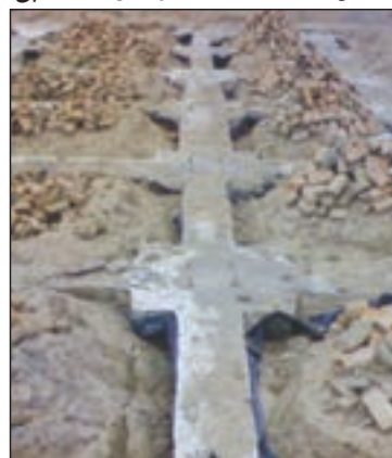
شکل ۳-۱۳۷ پی و شناژ بعد از بتن‌ریزی
