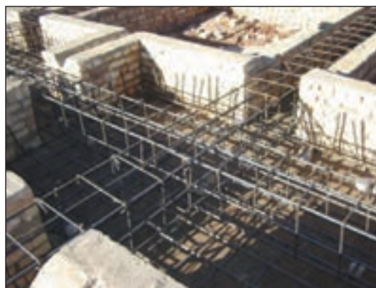
شکل ۳-۱۳۵ عبور میلگردهای شناژ در پی
