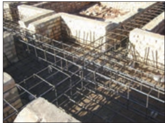
شکل ۳-۱۳۵ عبور میلگردهای شناژ در پی
