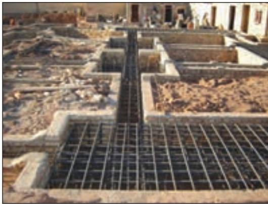
شکل ۳-۱۳۴ میلگردگذاری در پی کلاف بندی
