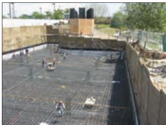
شکل ۳-۶۸ پی بتن مسلح یکپارچه (رادیه ژنرال)
