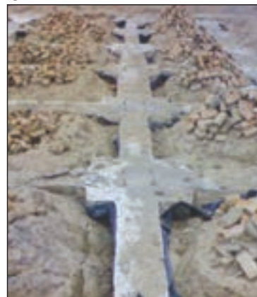
شکل ۳-۱۳۷ پی و شناژ بعد از بتن ریزی
