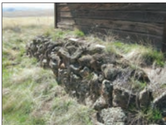
شکل ۳-۴۰ پی سنگی با سنگ لاشه
