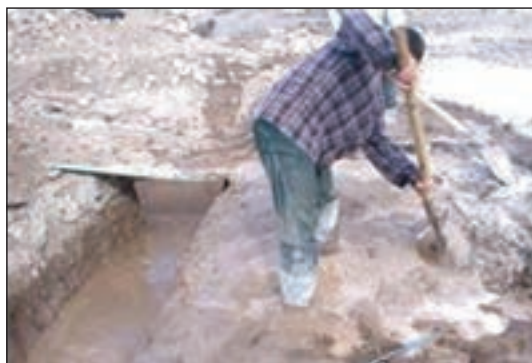
شکل ۳-۳۷ اجرای شفته آهک در فونداسیون
