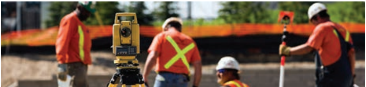
شکل ۴-۱. پیاده کردن با دوربین نقشه‌برداری
