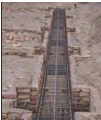
شکل ۳-۱۳۶ پی و شناژ قبل از بتن ریزی
