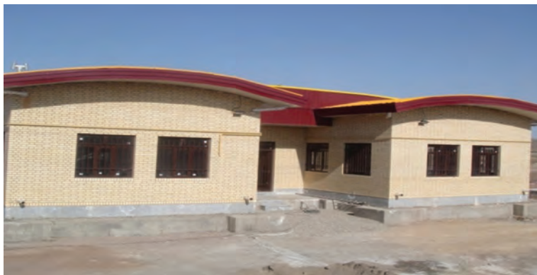
شکل ۳۲ - نمایی از یک راهدارخانه
