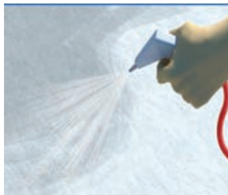
پاشیدن مواد نگهدارنده رطوبت بر سطح بتن
