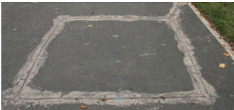
شکل ۲- نمونه نصب شده از حلقه‌های مغناطیسی
