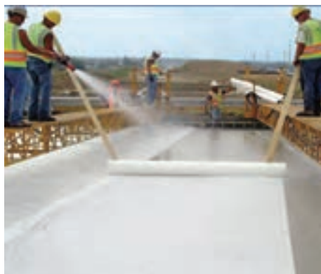
مرطوب کردن بتن و پوشش بانوار پلاستیکی
