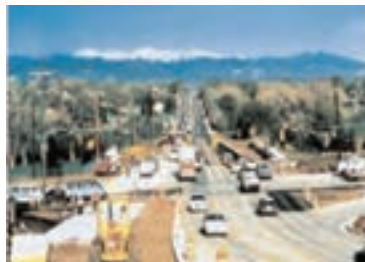
شکل ۳- سیمان‌های زودگیر، موارد استفاده (چپ به راست): بتن‌ریزی در هوای سرد، بهره‌برداری سریع از روسازی راه جهت به حداقل رسیدن ترافیک و باز کردن سریع قالب‌ها
