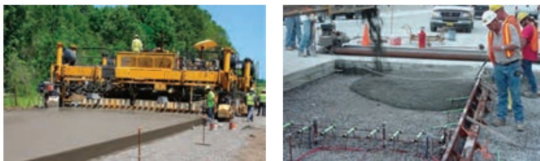
اجرای روسازی بتنی با استفاده از دستگاه
