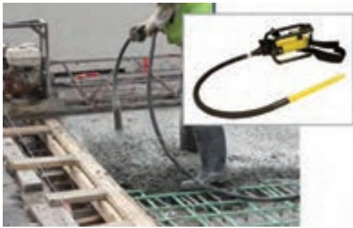
تراکم بتن تازه با دستگاه و بیره
