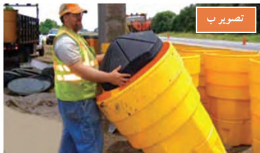
شکل ۲۲- چیدمان بشکه‌ها و قرار دهی مخروط درونی
