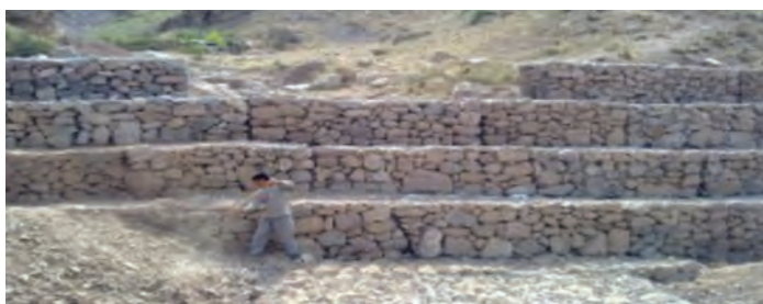
شکل ۳- دیوارهای توری سنگی (گابیون بندی) دیواره‌های ریزشی کوه
