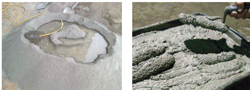
شکل ۱۸- طرز تهیه ملات ماسه سیمان
