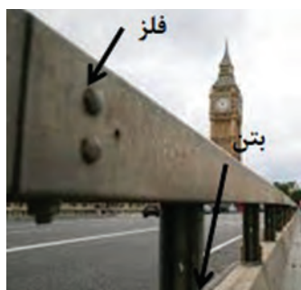
شکل ۳۳- نمونه حفاظ ترکیبی بتنی و فلزی
