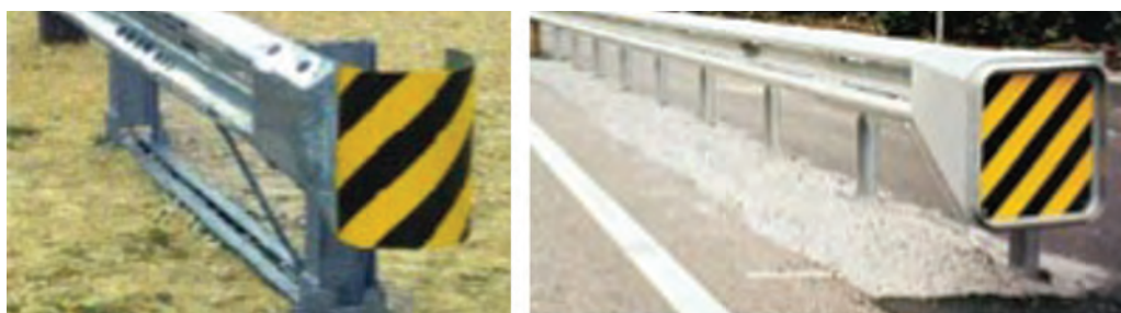
شکل ۷۳- نمونه‌هایی از مهارهای انتهایی و ضربه‌گیر
