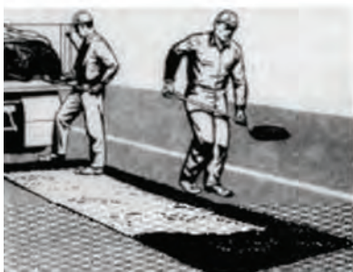
پر کردن محدوده لکه گیری با آسفالت
