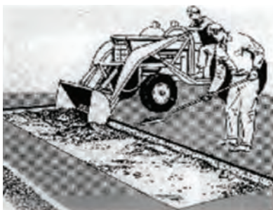
برداشتن لایه های آسفالتی و اساس
