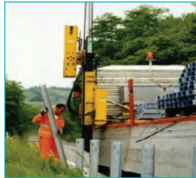
شکل ۳۴- چکش هیدرولیکی گاردریل کوب
