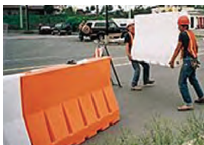
شکل ۳۰- حمل حفاظ پلاستیکی برای نصب در مسیر
