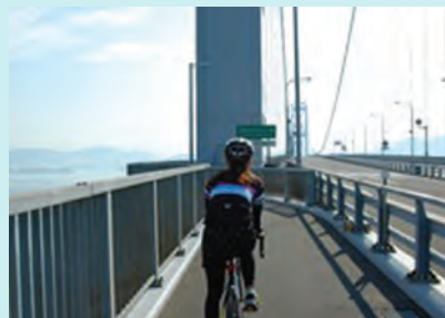
شکل ۷۷- ایمن سازی کناره های پل
