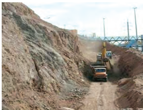
شکل ۱- اجرای عملیات خاک‌برداری
