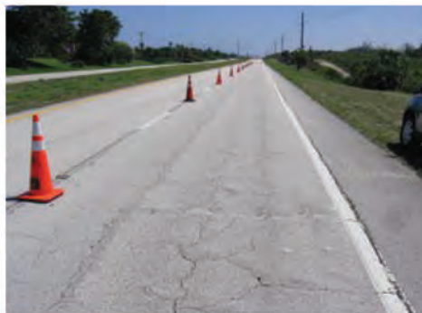
شکل ۳- ترک‌های بلوکی
