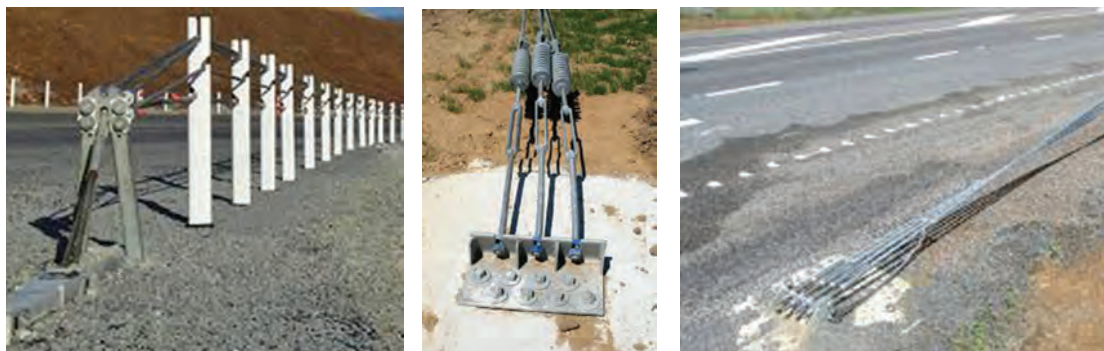
شکل ۲۰- نمونه‌هایی از انواع مهارهای حفاظ کابلی
