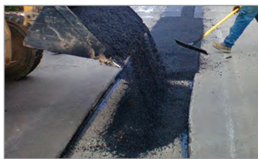
شکل ۴۰- روش ریختن و غلتک زدن
