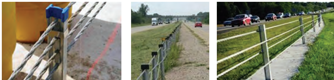
شکل ۴۶- نمونه‌هایی از اتصال کابل به پایه‌ها
