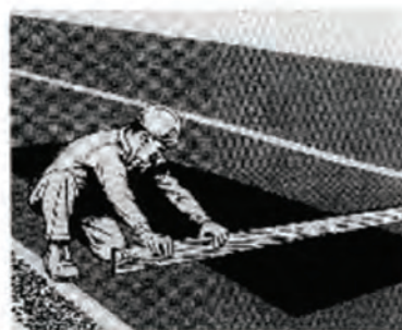
هم سطح کردن محدوده لکه گیری با روسازی مجاور
