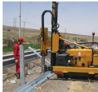
شکل ۴۲- پایه‌کوبی بعد از ریلی کردن سپری‌ها
