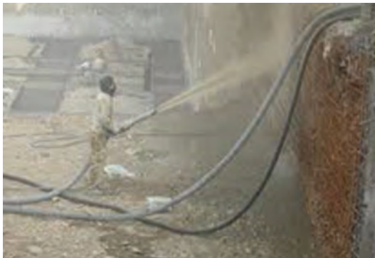
شکل ۲۰- اجرای بتن پاشی (شاتکریت) در بدنه سد
