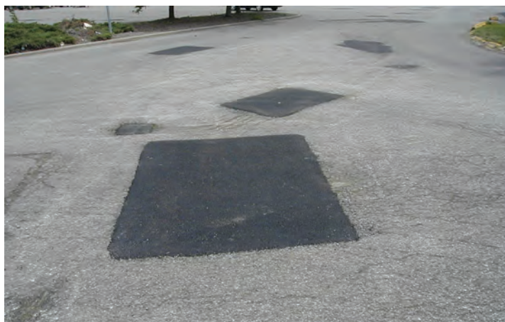
شکل ۹- نمونه‌ای از لکه‌گیری در روسازی آسفالتی
