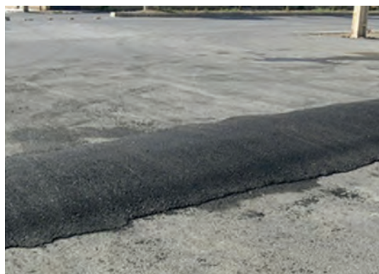
شکل ۹- ساخت سرعت‌گیر غیر استاندارد بتنی و آسفالتی
