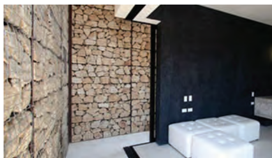
شکل ۵- دیوارهای توری سنگی (گابیون) نمای داخلی (غیرسازه‌ای)
