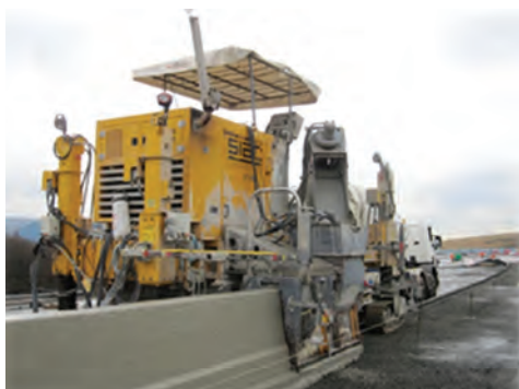
شکل ۵۰- ساخت نیوجرسی (بتن درجا به روش اتوماتیک)
