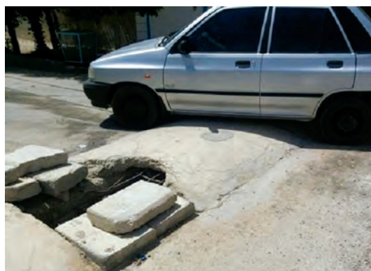
شکل ۹- ساخت سرعت‌گیر غیر استاندارد بتنی و آسفالتی
