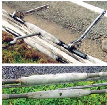
شکل ۴۸ - تنظیم کشش کابل
