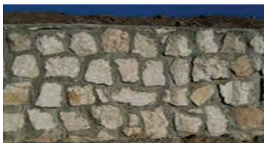
شکل ۱۷- استفاده از ملات در دیوارهای سنگی
