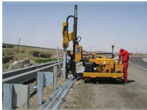
شکل ۴۴- پایه کوبی، نصب لقمه
