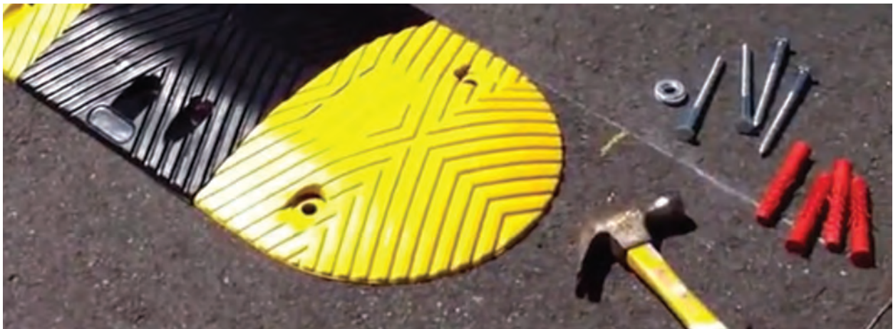
شکل ۱۲ - اجزای تشکیل دهنده یک سرعت گیر پلاستیکی
