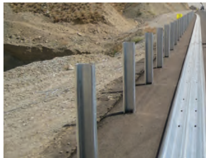
شکل ۴۲- پایه‌کوبی بعد از ریلی کردن سپری‌ها
