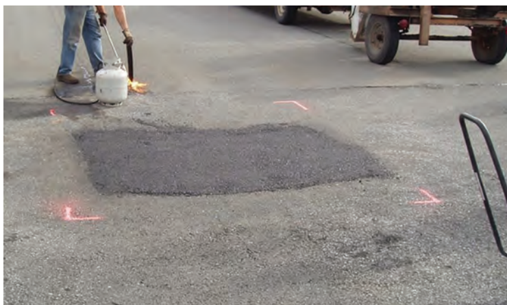
شکل ۳۹- نحوه مشخص کردن محدوده خرابی برای لکه‌گیری
