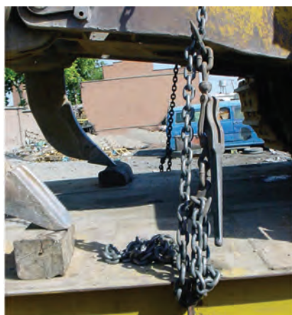
شکل ۲۷- بستن قسمت‌های مفصلی ماشین‌آلات راه‌سازی
