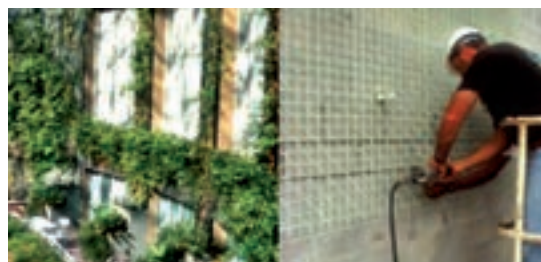
نصب پانل‌ها روی دیوار
