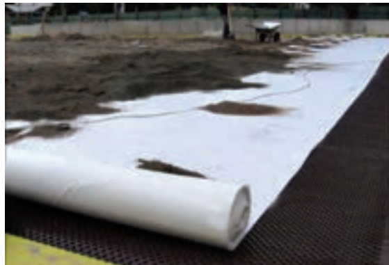
قرارگیری رول ژئوتکستایل در زیر بستر رشد
