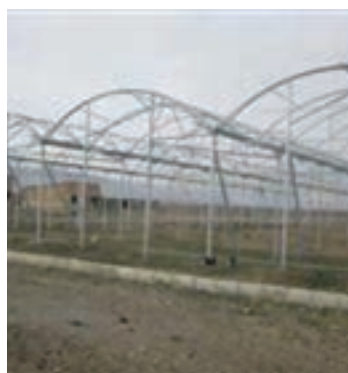
اسکلت گلخانه به سبک تونل - پیوسته
