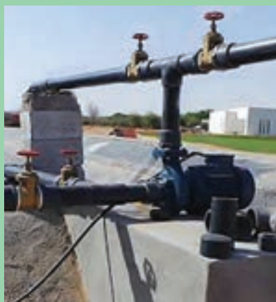
شکل ۱۰- شیر فلکه لوله رانش
