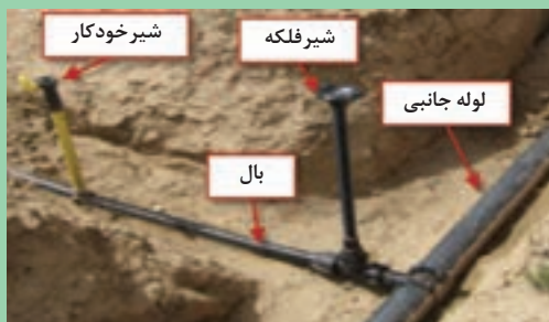
شکل ۱۱- محل شیر فلکه روی بال
