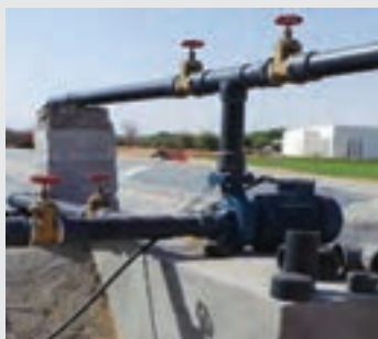
شکل ۱۸- شیرفلکه لوله رانش
