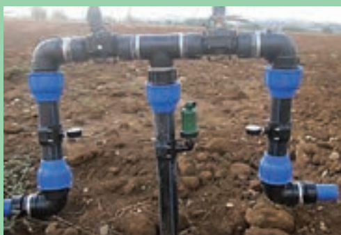
شکل ۱۸- شیر و فشارسنج روی بال ها
