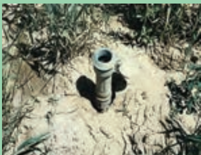
شکل ۱۲- شیر خودکار، رایزر و آبیاش
