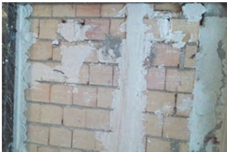
شکل ۲۴ ▲ شمشه‌گیری بین کرم‌ها
