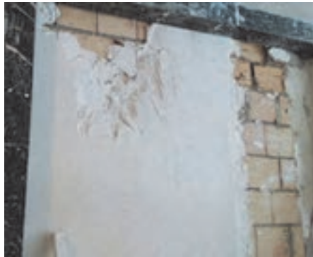
شکل ۲۵ ▲ پر کردن متن بین شمشه‌ها
